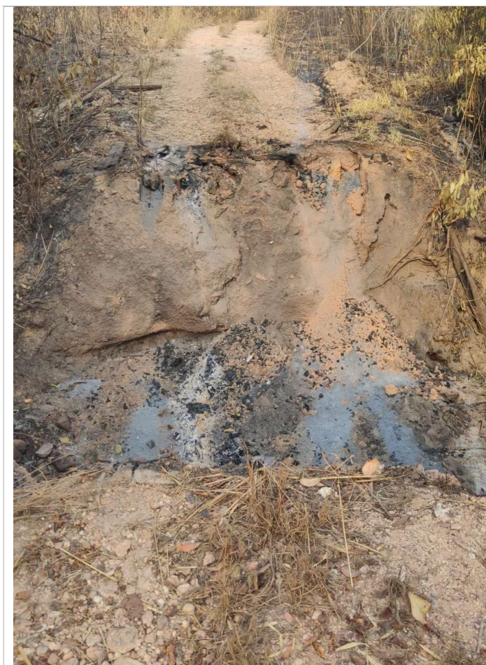
PONTE CÓRREGO AZUL 2
