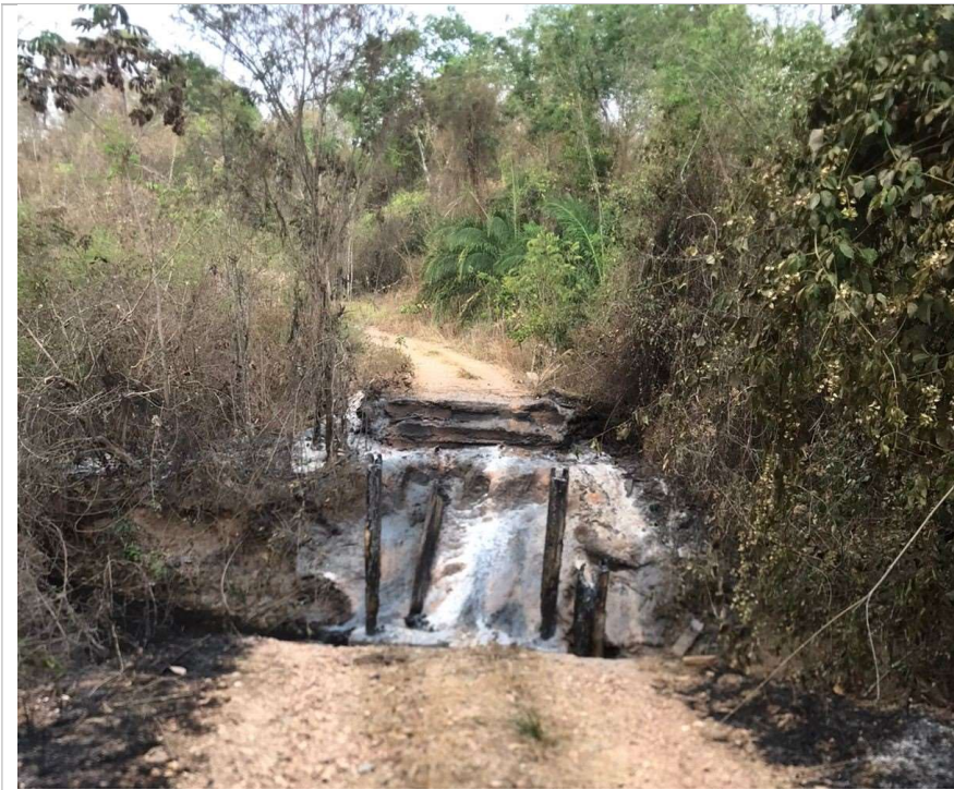
PONTE CÓRREGO FEIO 2
