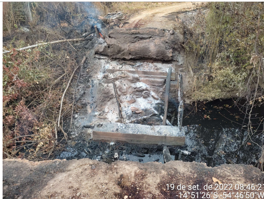
PONTE CÓRREGO AZUL 1
