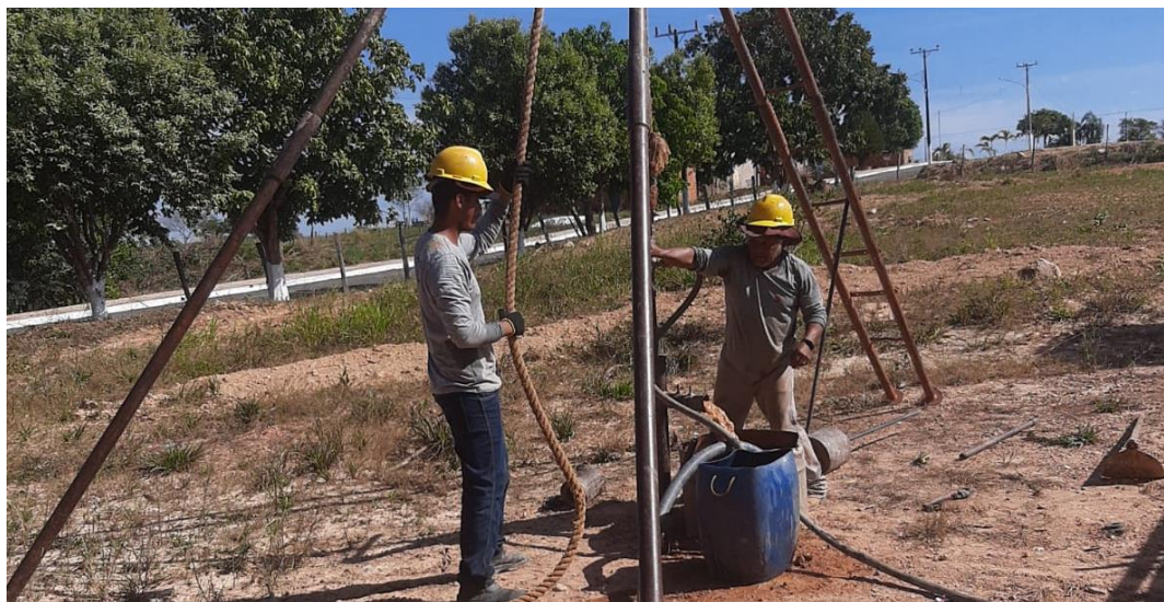
EXECUÇÃO DE SONDAGENS NO LOCAL
