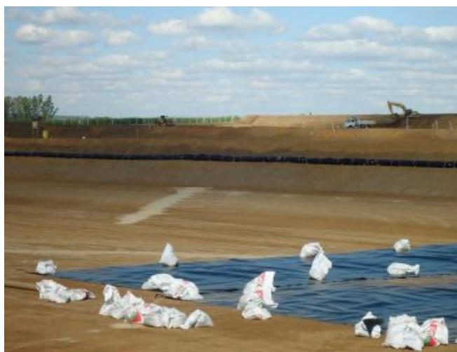
FIGURA 10 – EXEMPLO DE SACOS DE AREIA UTILIZADOS COM ANCORAGEM PROVISÓRIA (EVITAR AÇÃO DO VENTO). FONTE: NEOPLASTIC, 2016.
