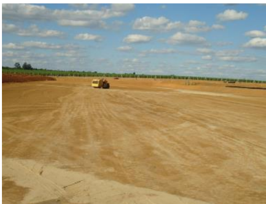
FIGURA 7 – TERRENO SENDO PREPARADO (NIVELADO) PARA A IMPLANTAÇÃO DAS MEMBRANAS FONTE: NEOPLASTIC, 2016.
