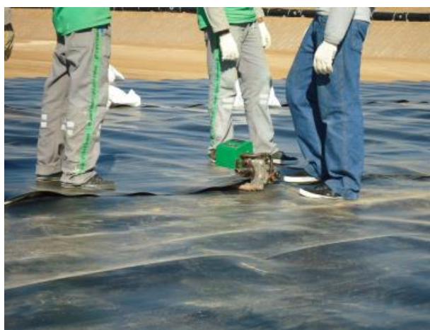
FIGURA 11 – EXEMPLO DE EXECUÇÃO DE SOLDA DUPLA POR TERMOFUSÃO COM MÁQUINA AUTOMÁTICA DE CUNHA QUENTE. FONTE: NEOPLASTIC, 2016.
