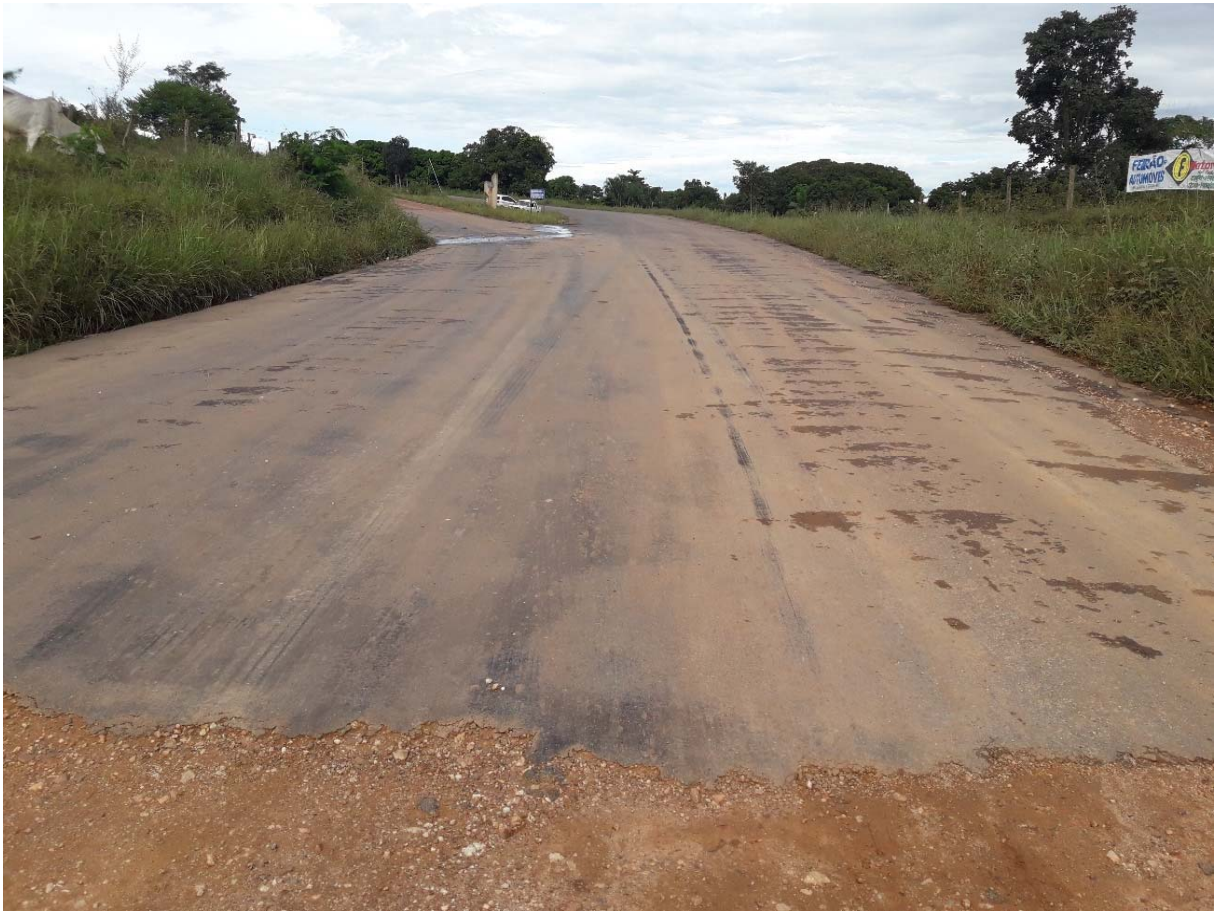
Foto 02: MT-140 –Perímetro Urbano- Fim do asfalto
