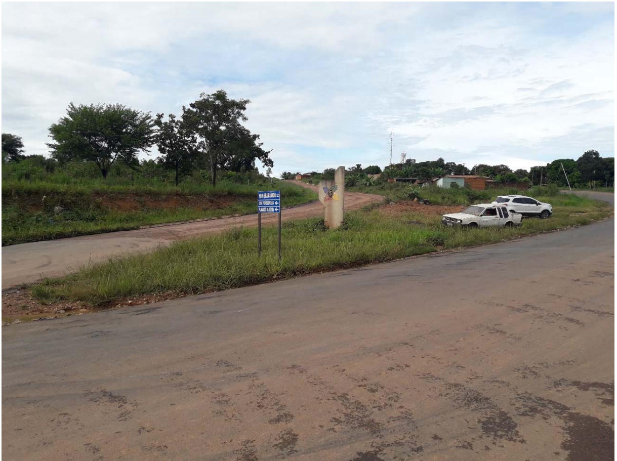
Foto 01: MT-140 / Av. Tancredo Neves com a Avenida Brasil
