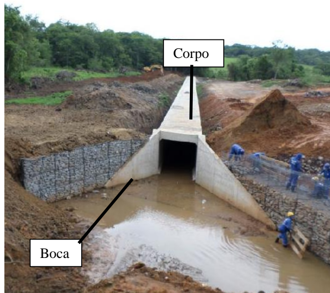
Figura 1. Partes constituintes de um Bueiro
